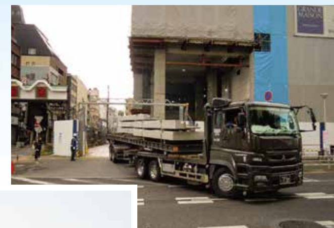
コンクリート壁搬入
